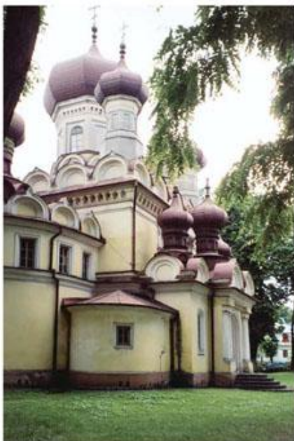
Cerkiew w Hrubieszowie osuszona w 2005 r.
