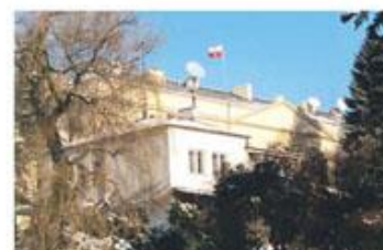
Siedziba Ministra Obrony Narodowej w Warszawie osuszona w 1995/96 r.
