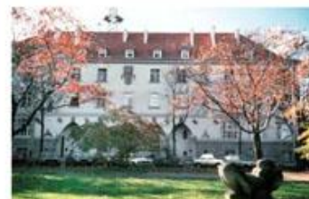
Budynek Dowództwa Marynarki Wojennej w Gdyni osuszony w 1994 r.
