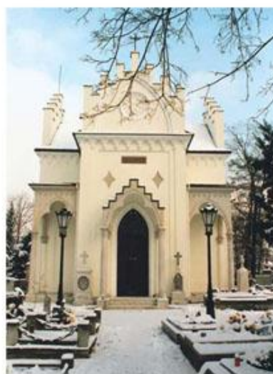
Zabytkowa kaplica na cmentarzu w Wilanowie w Warszawie osuszona w 1998 r.
