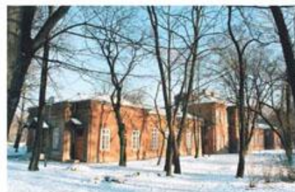
Centralna Biblioteka Lekarska w Warszawie na Jazdowie osuszona w 1996 r.
