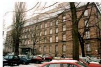
Budynek Inżynierii Łądowej Politechniki Krakowskiej w Krakowie osuszony w 1996 r.
