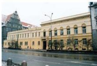
Budynek Sądu Apelacyjnego w Gdańsku osuszony w 1996/97 r.
