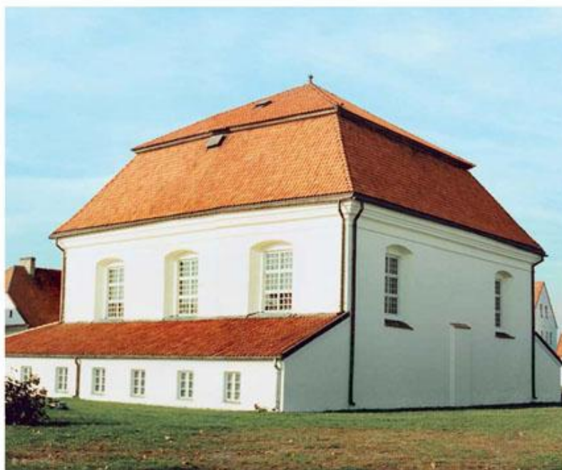
Synagoga w Tykocinie osuszona w 1992 r. Brak śladów zawilgoceń murów w przyziemiu (12.10.1997)
