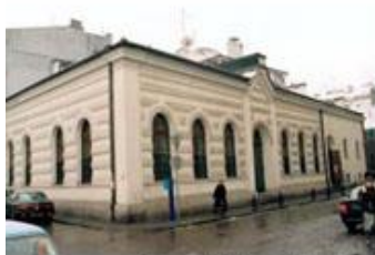
Centrum Kultury Żydowskiej w Krakowie osuszone w 1993 r.
