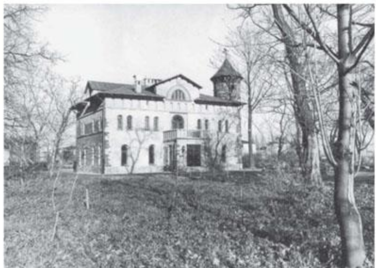
Zespół został osuszony w lipcu 1987 r., po niespełna 18-tu miesiącach wilgotność obniżyła się do poziomu ca 4%
