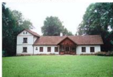
Budynek Muzeum Marii Konopnickiej w Żarnowcu osuszony w 2002 r.
