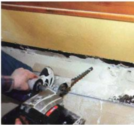
Wiercenie otworów iniekcyjnych
