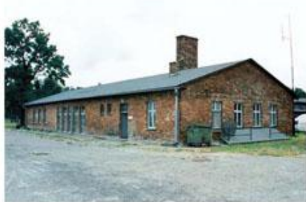
Budynek „Sauny” w Obozie Koncentracyjnym w Brzezince osuszony w 1998 r.
