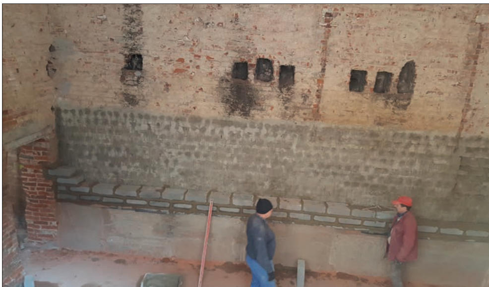
Fot. 1. Przykład realizacji geometrii otworów iniekcyjnych dla izolacji pionowej przeciwwilgociowej w technologii Iniekcji Krystalicznej®
